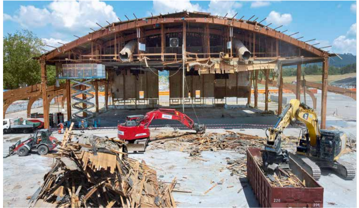
Beim Rückbau der alten Festhalle wurden sämtliche Materialien direkt auf der Baustelle sortiert und fachgerecht in die entsprechende Entsorgungs- oder Recyclingstelle zugeführt.
